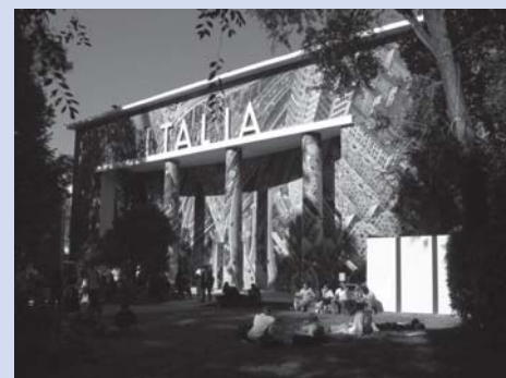
Lo storico Padiglione "Italia" riprospettizzato ai Giardini di Sant'Elena
