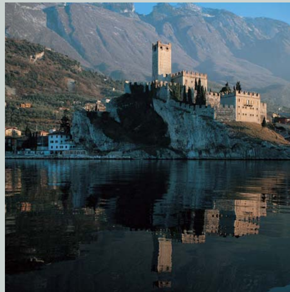
Malcesine, lago di Garda • Il Castello Scaligero Malcesine, Lake Garda • Scaligeri Castle
